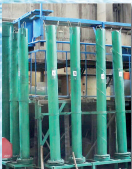
Установка кучного выщелачивания Казмеханобра
