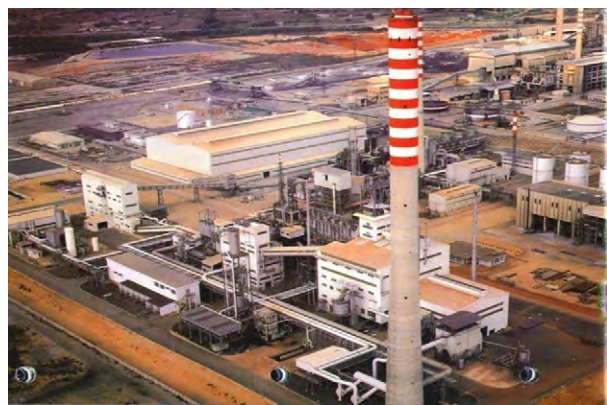
Рис. 2 – Комплекс КИВЦЭТ на заводе Portovesme S. r. l., Италия
