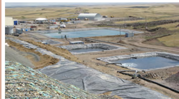
Рис. 7 – Кучное выщелачивание руды месторождения «Аяк-Коджан»
