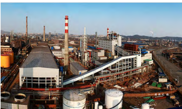
Рис. 3 – Комплекс КИВЦЭТ на заводе Zhuzhou Smelter Group, Китай
