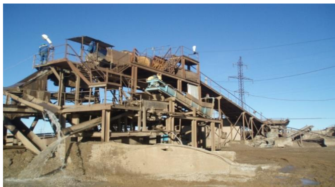
Рисунок 2 – Сезонная обогатительная установка ТОО «Стройсервис»
